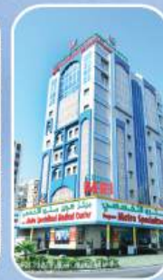
مركز سوبر مترو التخصصي - السليمانية Super Metro Specialized Medical Center - Salmiya
